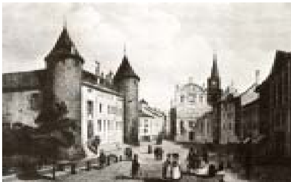
Castelo de Yverdon (entre 1805 e 1825)
